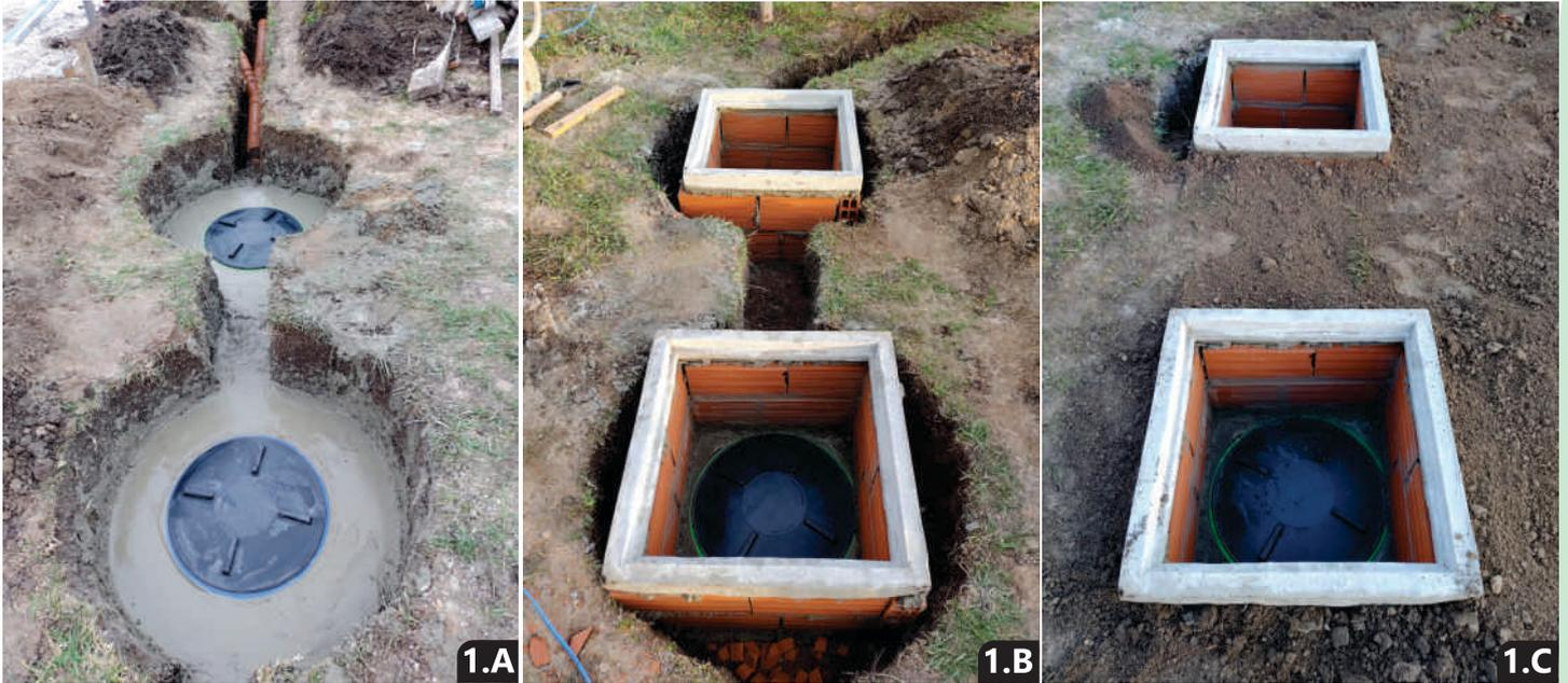
Rellenado progresivo (fragüe de primera mitad, luego completar hasta nivel deseado) de hormigón liviano hasta el nivel de tapas "imagen A". Alcanzado el endurecimiento de la zona, se realizó la prolongación para alcanzar "nivel 0" en marco de tapa de inspección mediante fijación de hileras de ladrillo pegado, "imagen B". Luego de fragüe final se relleno y completó con tierra la zona, "imagen C".
