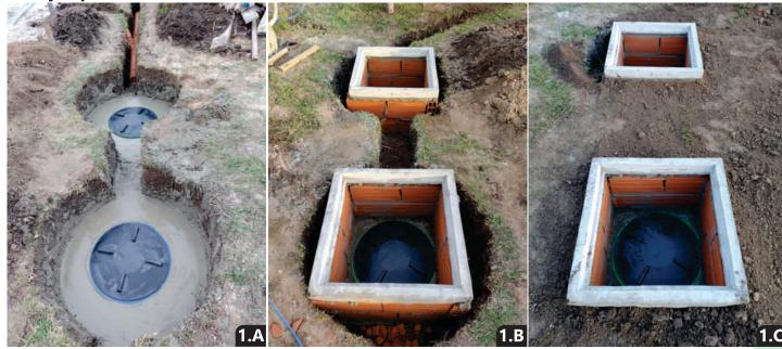
Rellenado progresivo (fragüe de primera mitad, luego completar hasta nivel deseado) de hormigón liviano hasta el nivel de tapas "imagen A". Alcanzado el endurecimiento de la zona, se realizó la prolongación para alcanzar "nivel 0" en marco de tapa de inspección mediante fijación de hileras de ladrillo pegado, "imagen B". Luego de fragüe final se rellenó y completó con tierra la zona, "imagen C".
